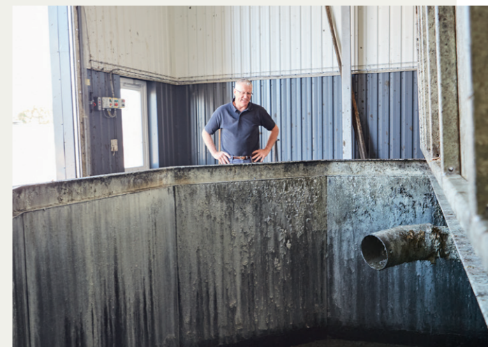
Alle råvarerne puttes i blandekarret, inden det sendes ind i anlægget. Foderplanen er afgørende for en god økonomi i anlægget.
